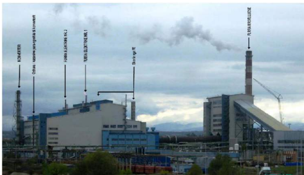
Pamje nga ferro nikeli dhe pikat e matjeve të emisioneve nga tymtarët
