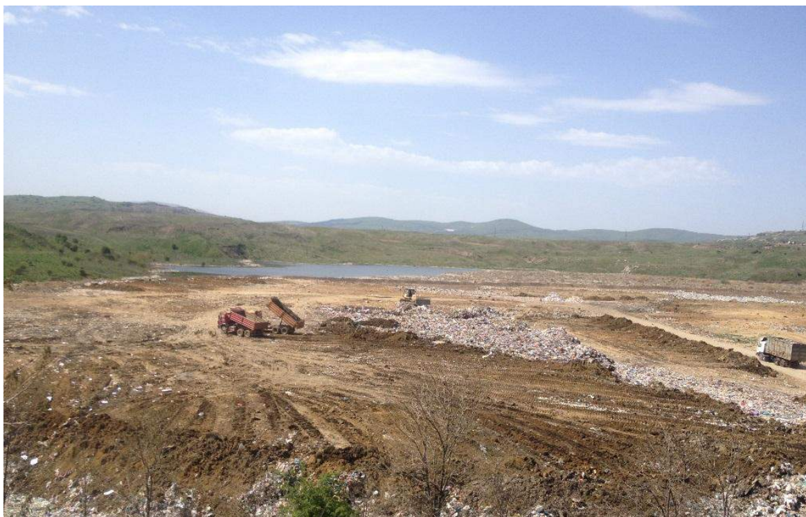
Mbulueshmeria e mbeturinave me shtresa të dheut në deponinë sanitare në Mirash
