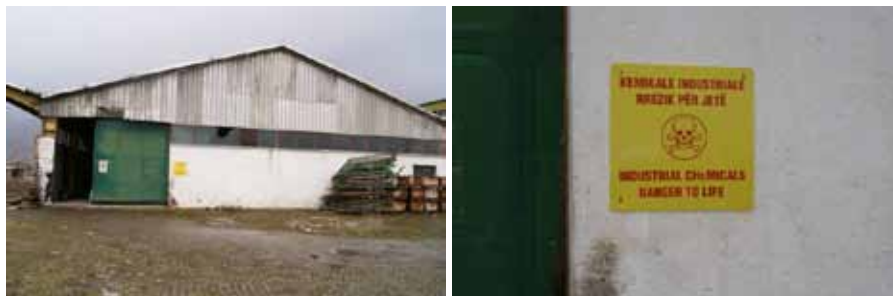
Objekti i deponimit të kemikateve industriale në Pejë
