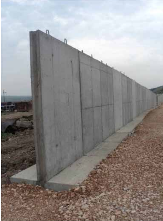
Pamja tërthore e murit nga betoni në Sibofc
