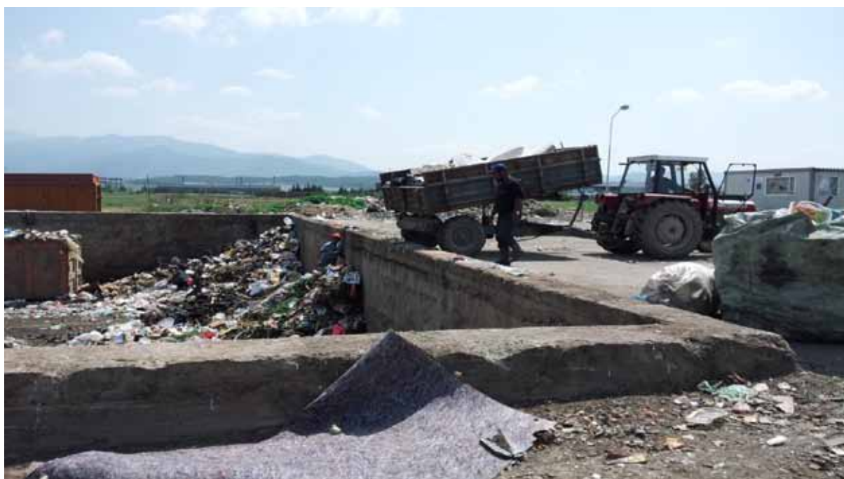
Stacioni transferues i mbeturinave në Gjakovë
